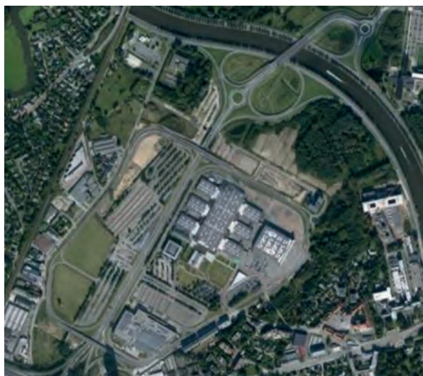
Afb. 79: Luchtfoto van bedrijventerrein ‘The Loop’
