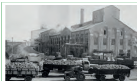
Fig. 90: Le site historique de la Sucrerie de Furnes
