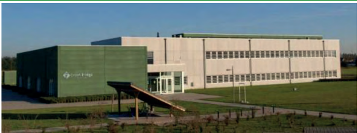
Fig. 40: Bâtiment industriel écoénergétique - Incubateur Greenbridge
