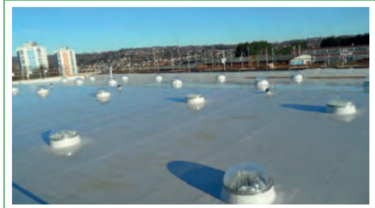
Fig. 47: Puits de lumière ou tubes solaires – Theaklen Drive
